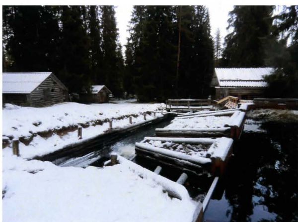
Läget inför vintern - rämnorna under kvarnen klara och staketet och de översta stocklagren borttagna
