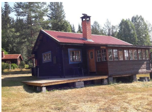
Monas och Kalles hus sett från söder
