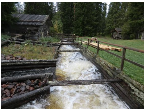
Utgångsläget innan utbytet av halvkluvorna
